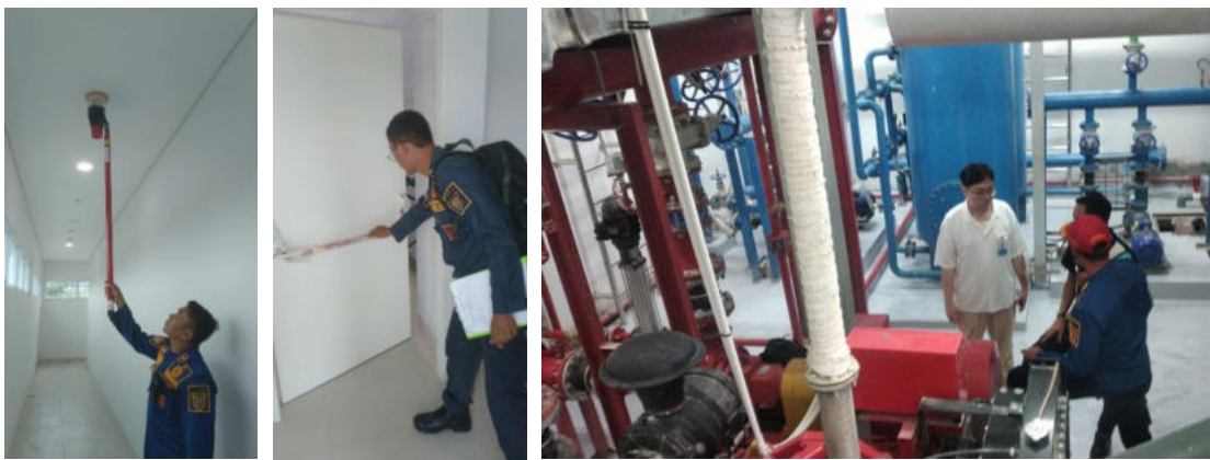
Gambar 5. Inspeksi Sistem Proteksi Kebakaran
